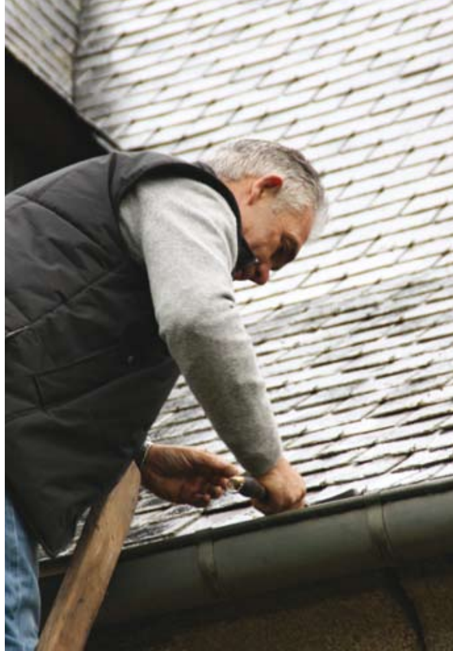
Entreprise de couverture Jean-Marc Brochard (35)
